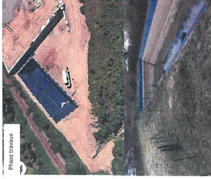
FIGURE 31 : BASSIN DE RETENTION DES EAUX PLUVIALES ET DES EAUX D'EXTINCTION D'INCENDIE
